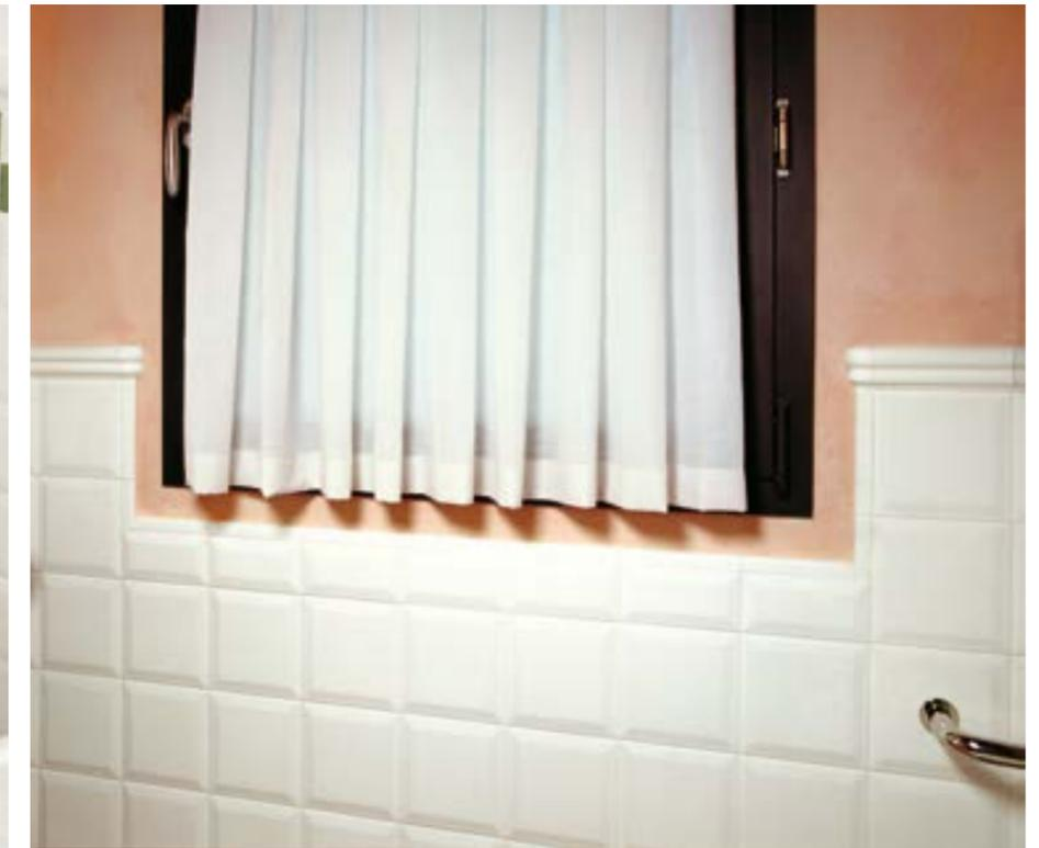
In prossimità di porta e finestra, fermarsi con la posa all'ultima piastrella intera, utilizzando il Bullnose per rifinire la costa non smaltata della piastrella stessa e il terminale dx/sx per cornice e battiscopa.
